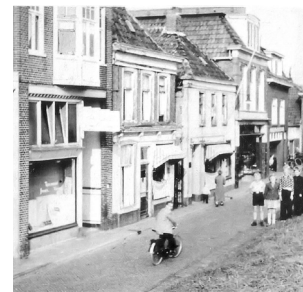
De Oude Schans in de jaren 70 laat zien hoe de straatwand ook varieerde in hoogte.
